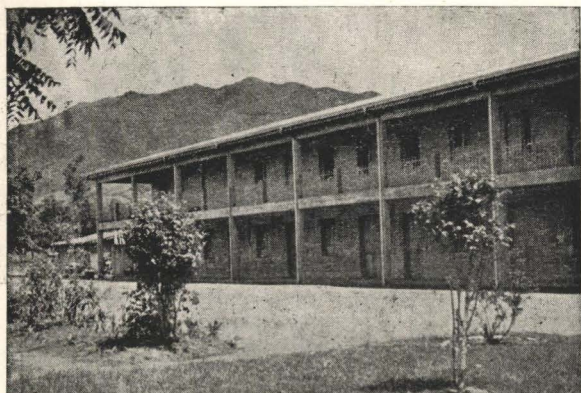
La Ceja - Tramo en edificación
