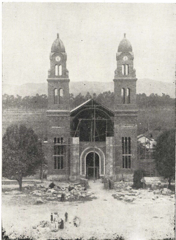
La nueva iglesia parroquial en construcción - 1949
